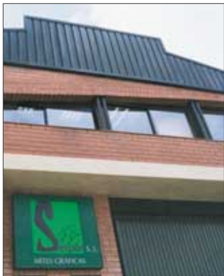
Vista parcial del edificio de Serper.
